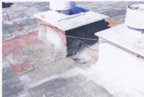
Obr. 7: Nevhodně umístěná vpusť mezi nástavbami vzduchotechniky, střecha D 2
