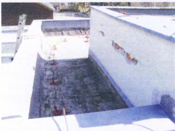
Obr 4: Poruchy u zdiva nástavby střechy C
