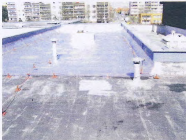
Obr. 5: Severní část střechy A' je natřena reflexním hliníkovým nátěrem
