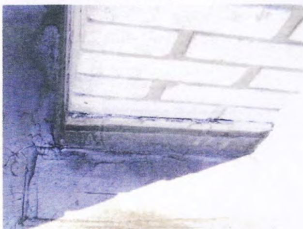
Obr. 12: Trhliny u zdivu střešní nástavby - komínu, trhliny v asfaltových pásech u detailu
