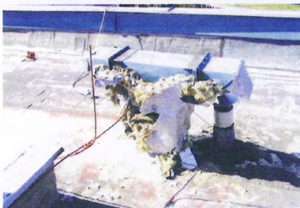
Obr. 6: Poškozená tepelná izolace u detailu vzduchotechnického potrubí, střecha D 2
