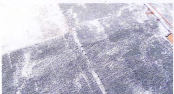
Obr. 8: Praskliny na povrchu asfaltových pásů
