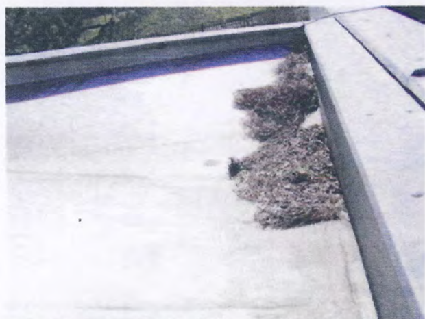
Obr. 13: Napadané jehličí na střeše H, střecha s fóliovou střešní krytinou
