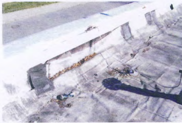
Obr. 3: Odpadlá hydroizolace u atiky, střecha D 2 , oblast, kudy zatéká
